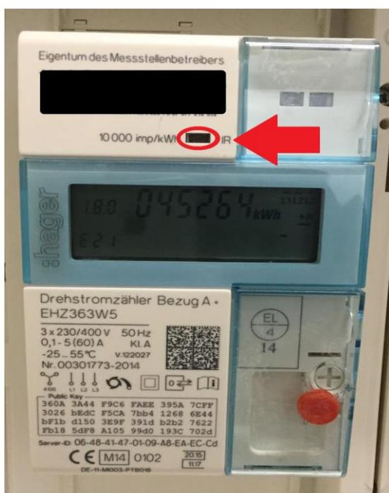
1. Im Lieferumfang befindet sich eine Unterlegscheibe mit doppelseitigem Klebeband. Kleben Sie die Unterlegscheibe über die IR Schnittstelle (LED Port) des Sicherungskastens, so dass die Öffnung der IR Schnittstelle frei bleibt.
